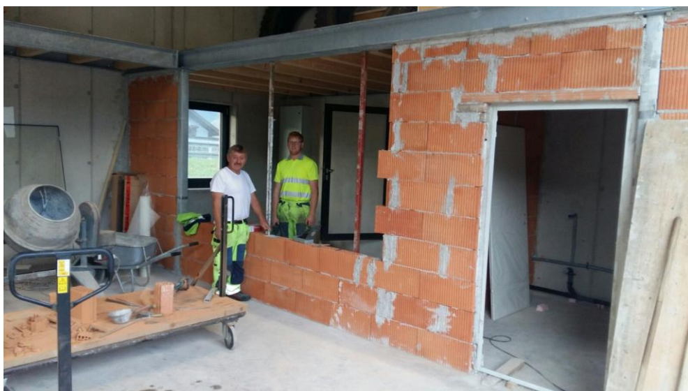
Bild oben rechts: Arbeiten am Bauhofpersonalraum
